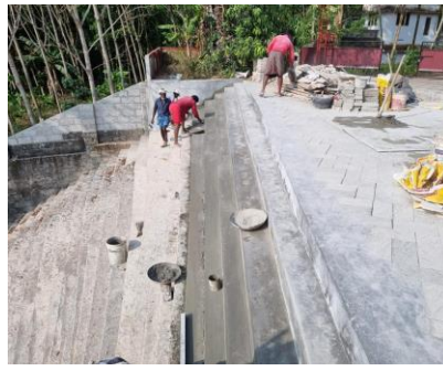
musste repariert werden und
